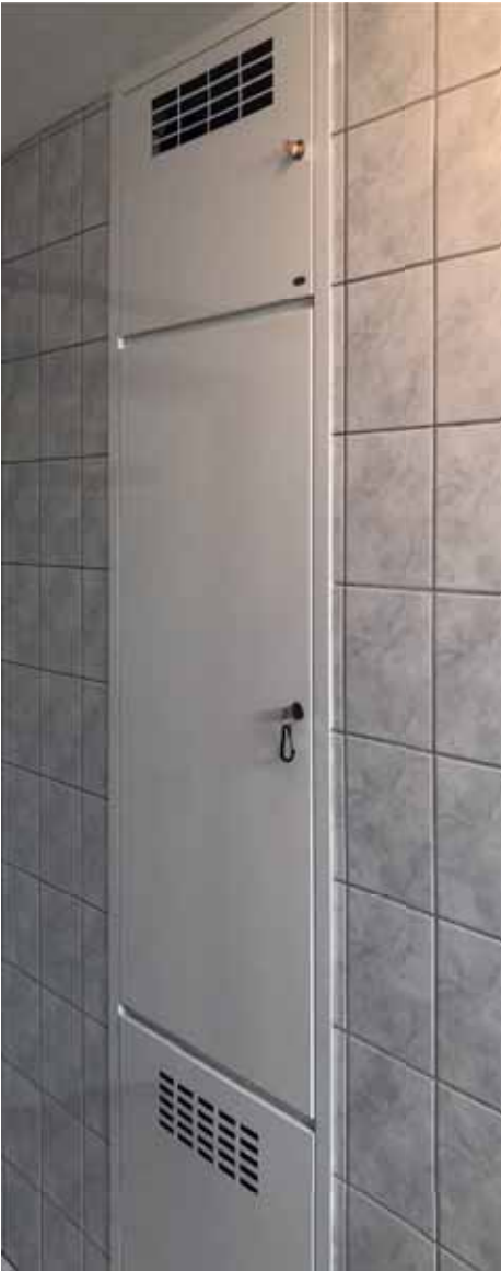
295/1 Verkleidung einer Unter Putz Gastherme
